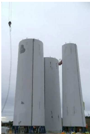
Torre de hormigón
