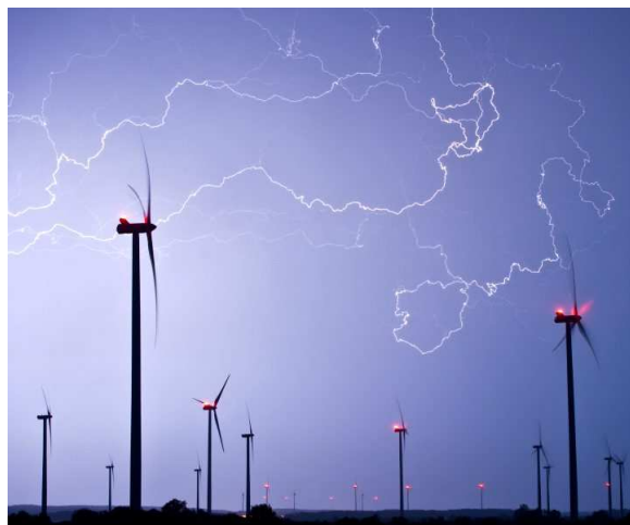
Tormenta eléctrica en un parque eólico
