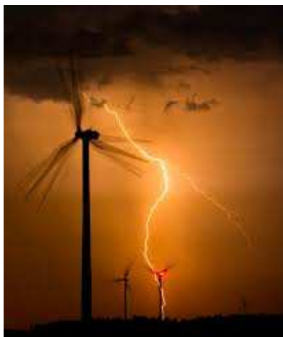
Caída de rayo en aerogenerador
