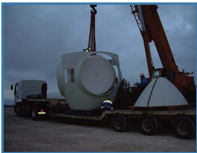
AFECCIONES EN EL BUJE, FIBRA, PINTURA
