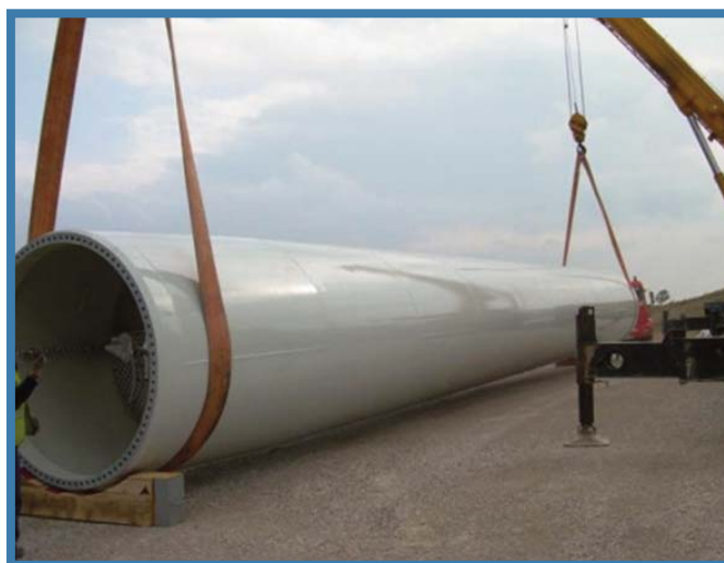
AFECCIONES EN TUBOS, PINTURA
