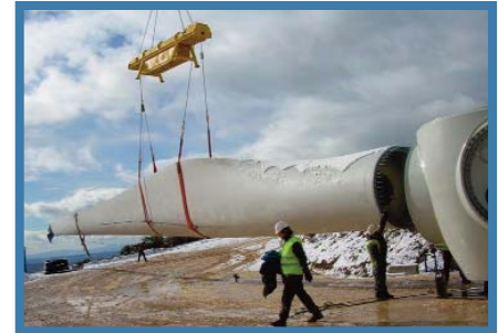
Fotografía elevación pala
